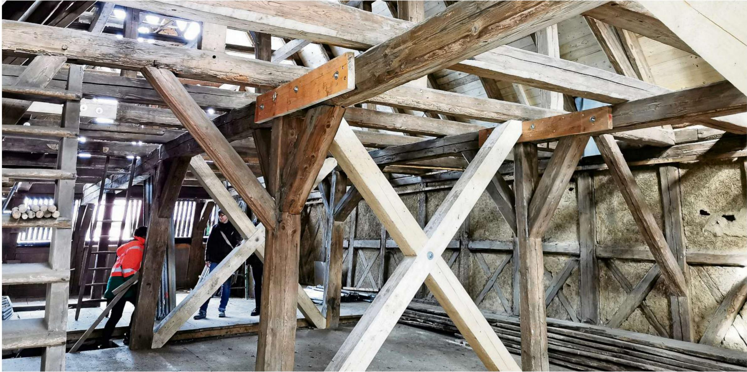
Der Dachstuhl des Hopfenspeichers in Hornburg wird abgestützt durch sogenannte Andreascreuzen zur Querversteifung.
