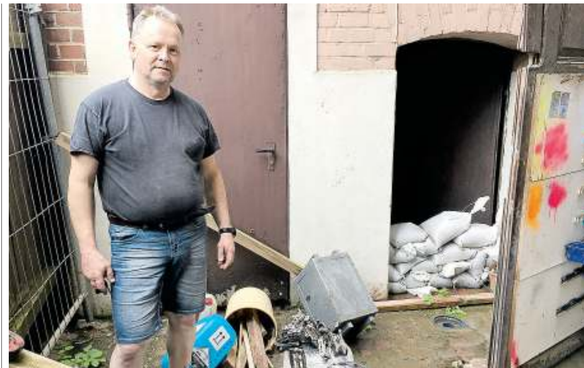
Der Wolfenbütteler Reinhard Fischer hat den Kampf gegen das Hochwasser verloren. Sein Keller lief voll. Sein Haus steht direkt neben dem sogenannten „Klein Venedig“ in der Lessingstadt.
